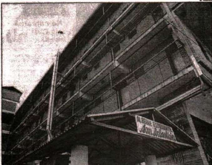
Para arriba. Son cada vez más los edificios que funcionan como albergues universitarios.
