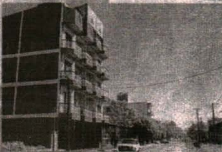
Detenido. La edificación de Albergues sigue avanzando.
