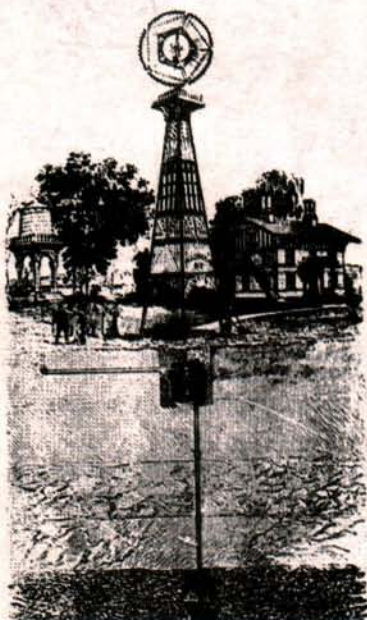
Molino "Corcoran" totalmente de madera con el tanque separado simulando un pabellón.
